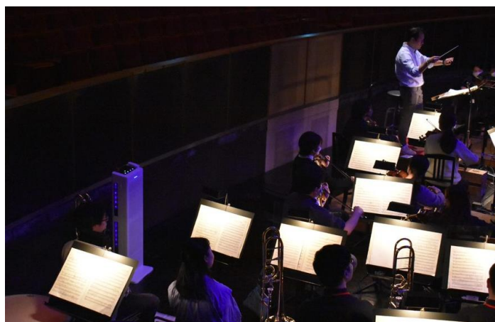
オーケストラピット内に設置された据え置きタイプ光触媒除菌脱臭機
